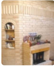
Mur intérieur en briques de terre crue
