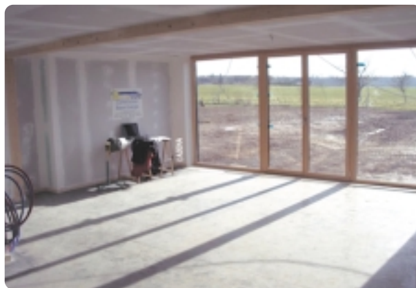
Baie vitrée orientée au sud : apports solaire importants en hiver
